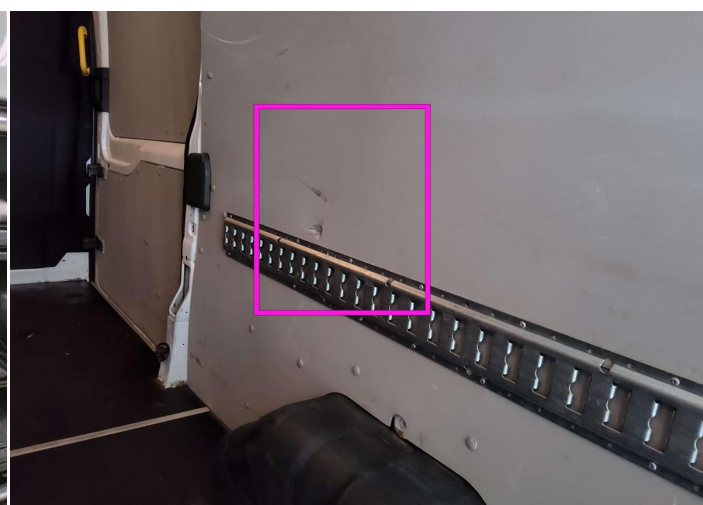
18. Panelfyldning / tilbage - højre Indvendig / holed -
